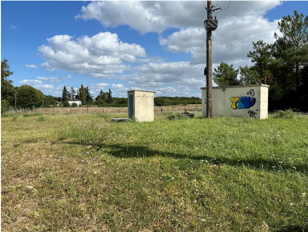
Figure 23 - Forage et piézomètre de la Pavais à Chartres-de-Bretagne situés entre les deux bâtiments (source : BRGM)
