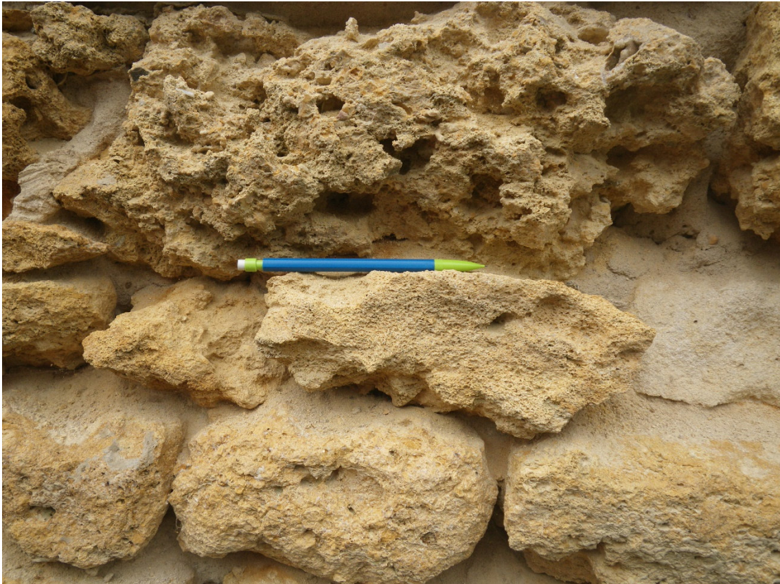
Figure 16 - Détail de porosités différentes au sein des roches d'un mur du monument des fours à chaux (source : BRGM)
