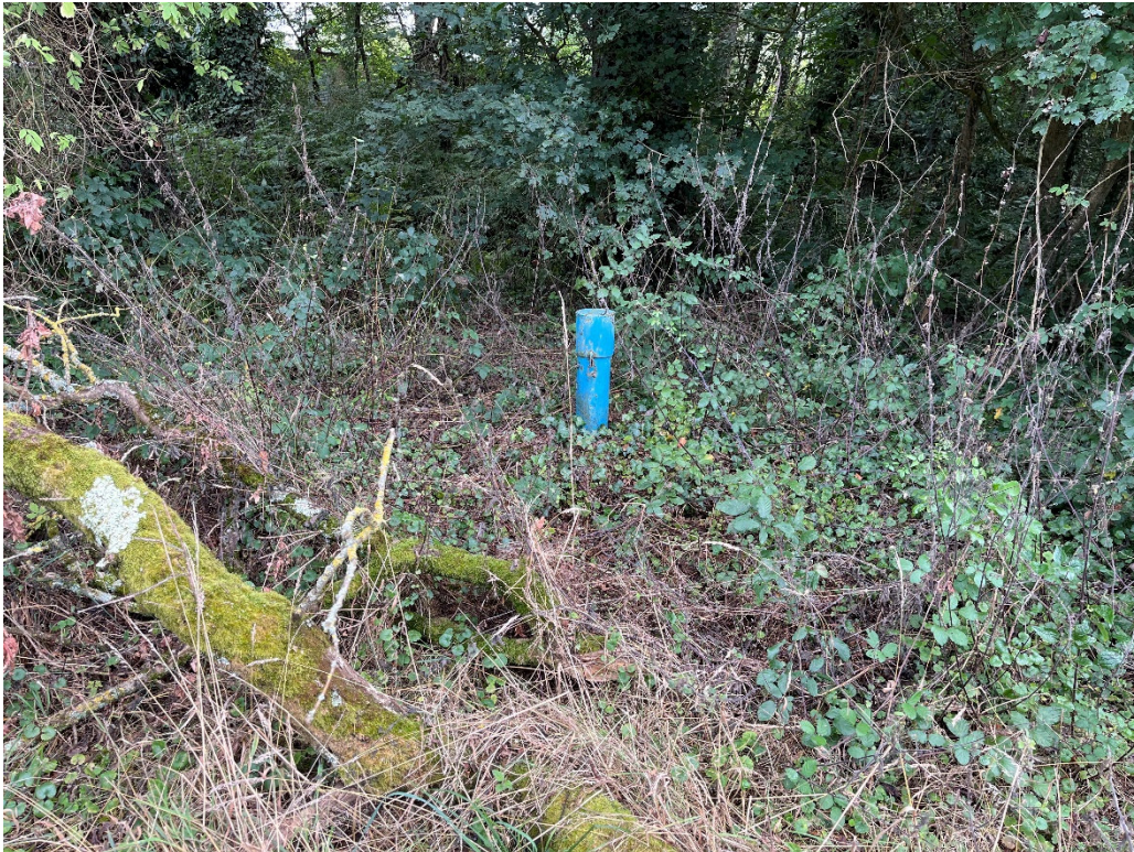
Figure 21 - Piézomètre Pz1 au sentier Lormandière (source : BRGM)
