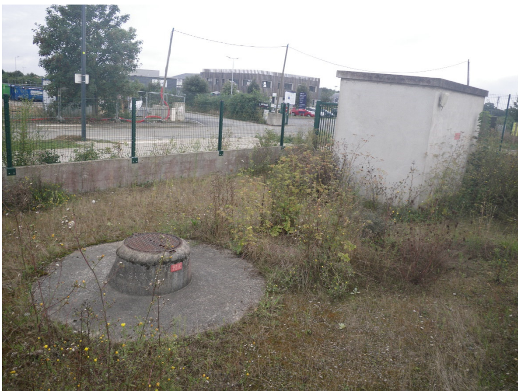
Figure 26 - Piézomètre PzH du Groupe Stellantis (source : BRGM)
