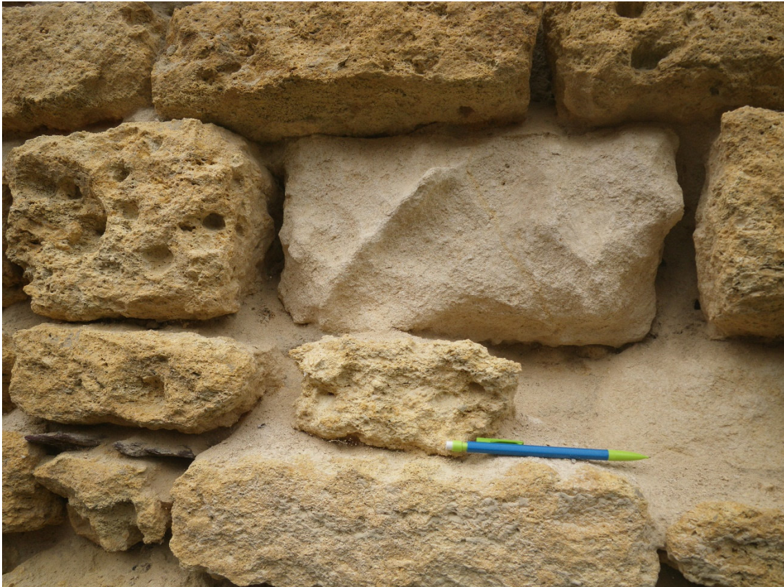
Figure 13 - Photographie des différentes roches composant un mur du monument des fours à chaux : faluns miocènes jaunâtres entourant une roche plus blanche composée de calcaires oligocènes (source : BRGM)
