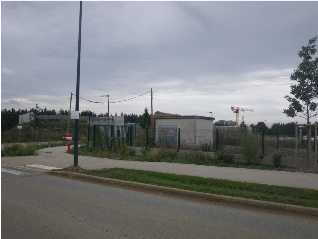
Figure 24 - Site d'un forage d'eau industrielle du Groupe Stellantis (source : BRGM)
