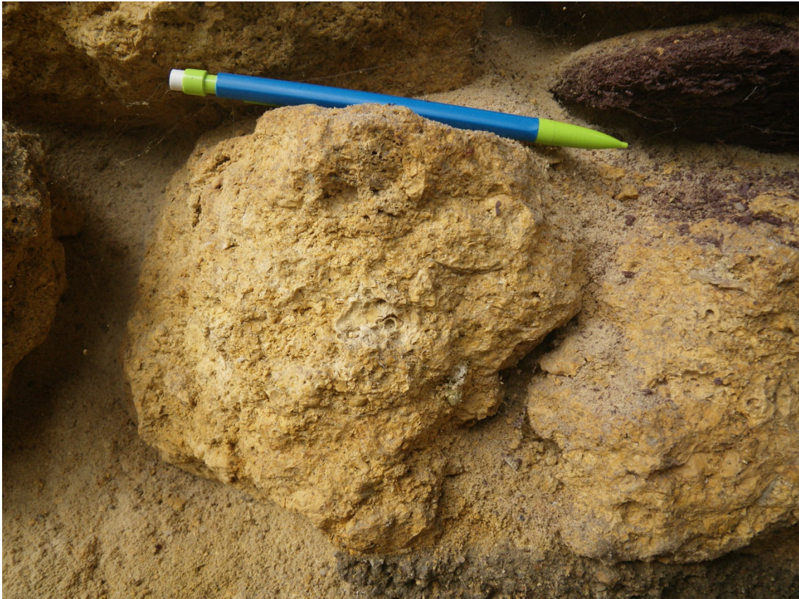
Figure 15 - Aperçu des débris coquillers dans les faluns miocènes d'un mur des fours à chaux (source : BRGM)
