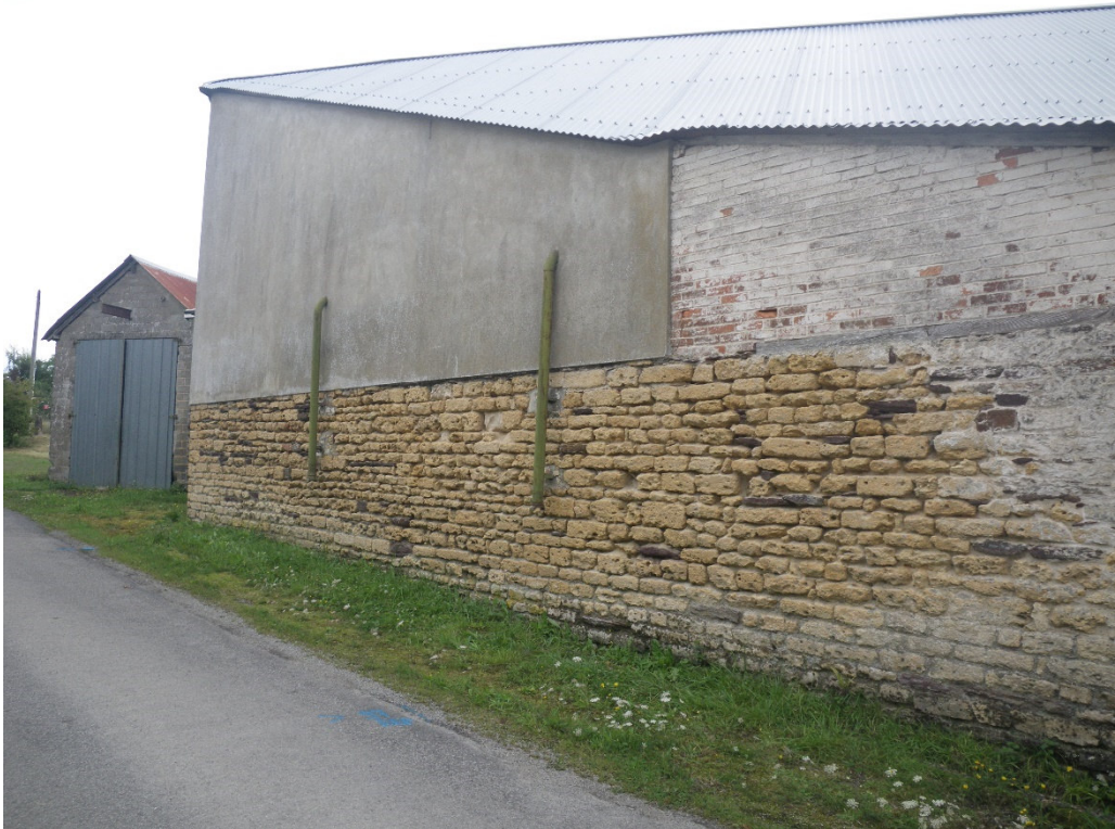
Figure 12 - Exemple d'un mur en bord de route du monument des anciens fours à chaux du lieu-dit Lormandière (source : BRGM)
