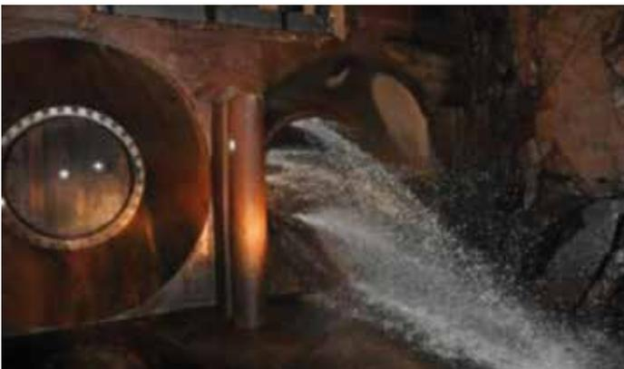
*Aperçu dans la chambre des vannes de la file n°1 avec pose de la conduite entre les vannes amont et aval.*
